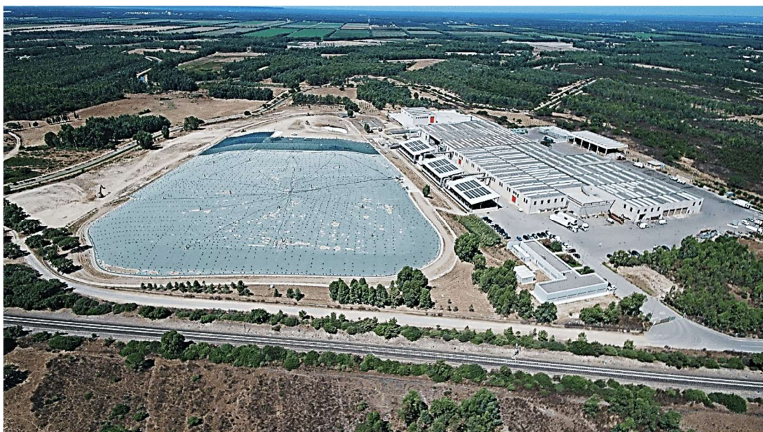
Foto aerea discarica in fase di copertura
