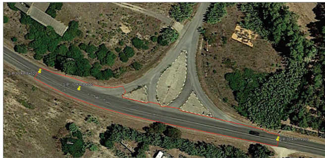
Intersezione Crossodromo Riola - zona d'intervento con fresatura
